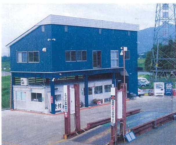
本社事務所と放射線検知器付台
